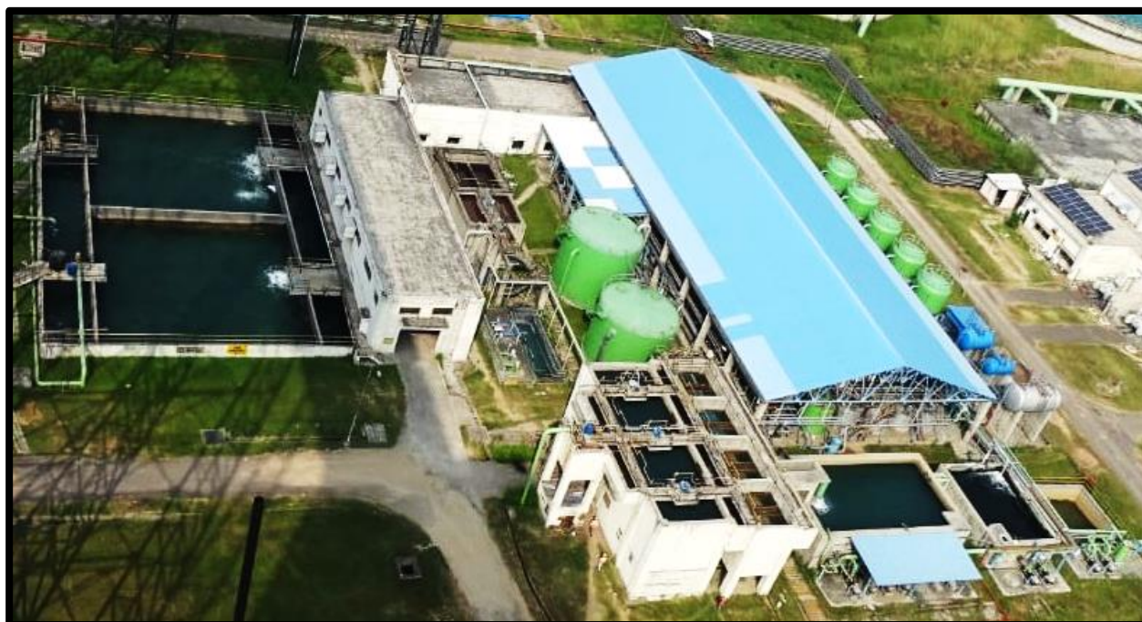
Pic-1 Effluent Treatment Plant.
