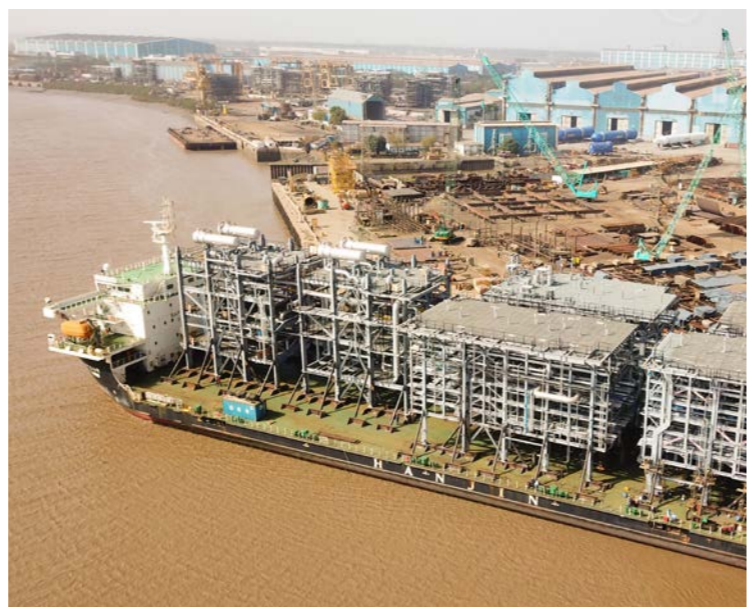
Onshore PAU & PAR Modules for Clean Fuels Project, Thailand
