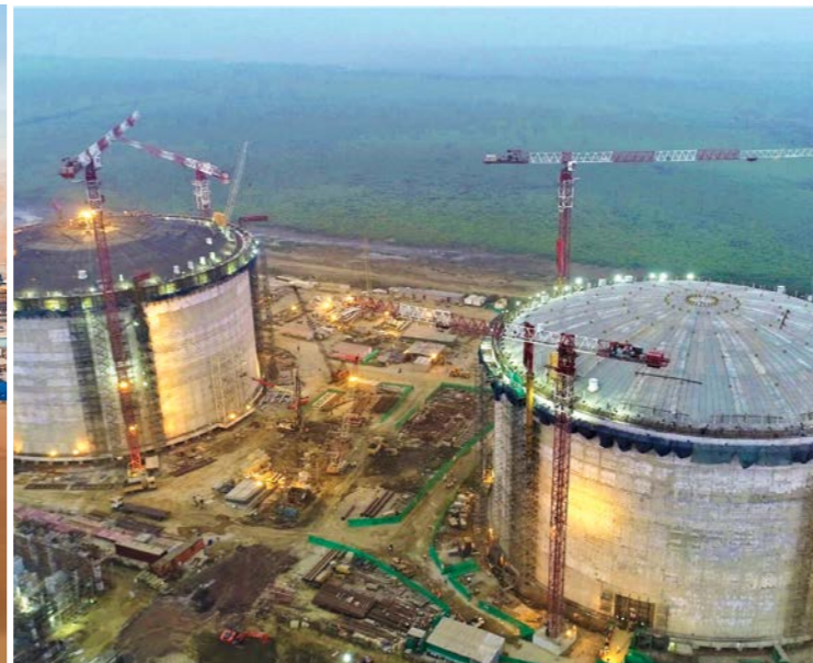
LNG Tanks under construction for Adani's Dhamra LNG Terminal, India
