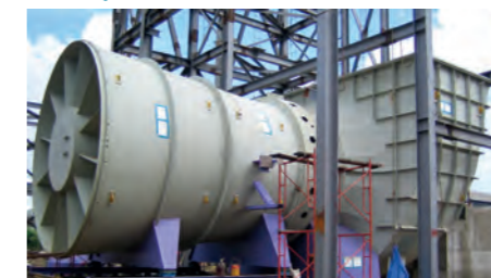
4 A-position booster fan
