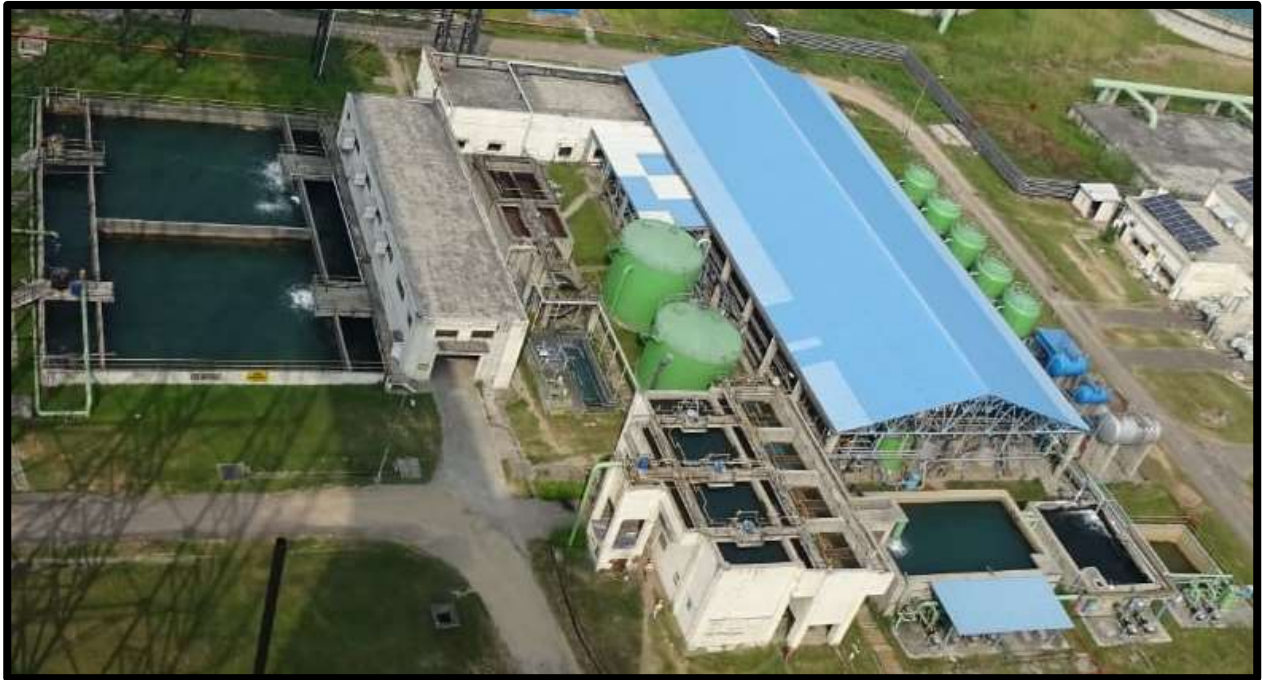
Pic-1 Effluent Treatment Plant.
